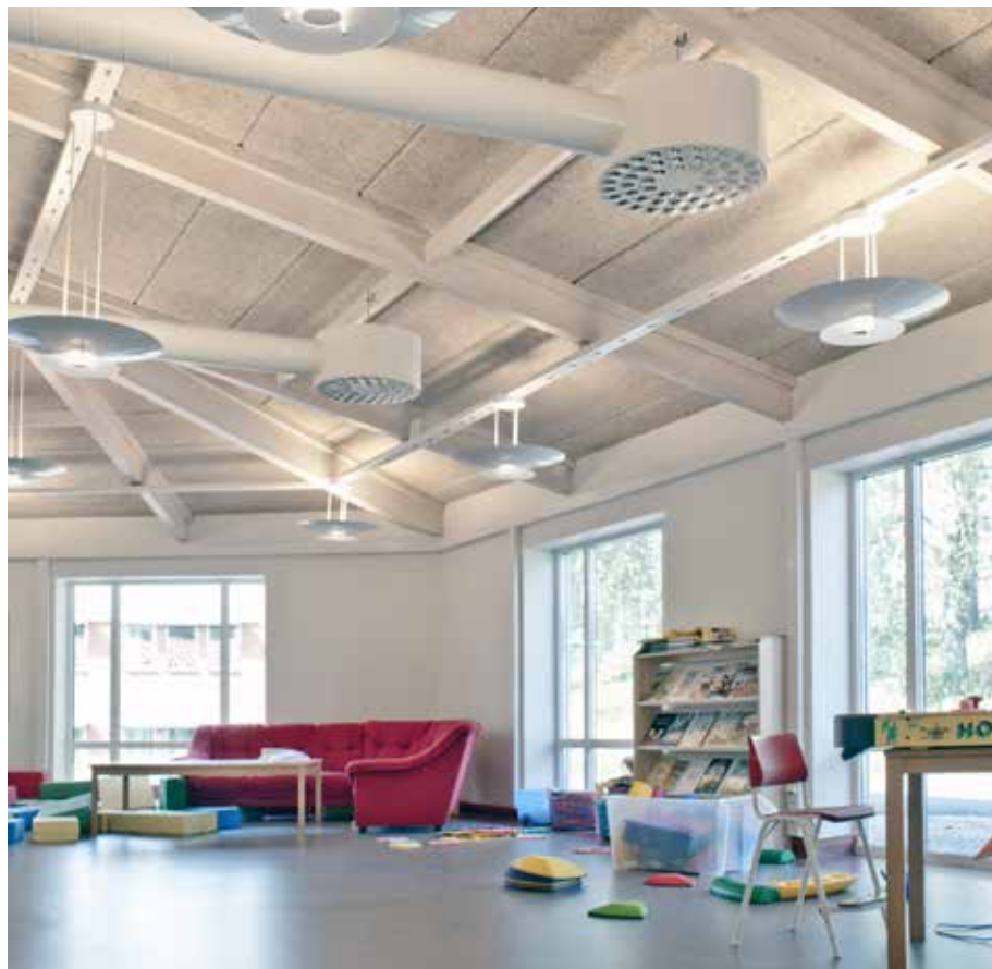
Österbymo Förskola | Ydre Yttertak och helväggslement
