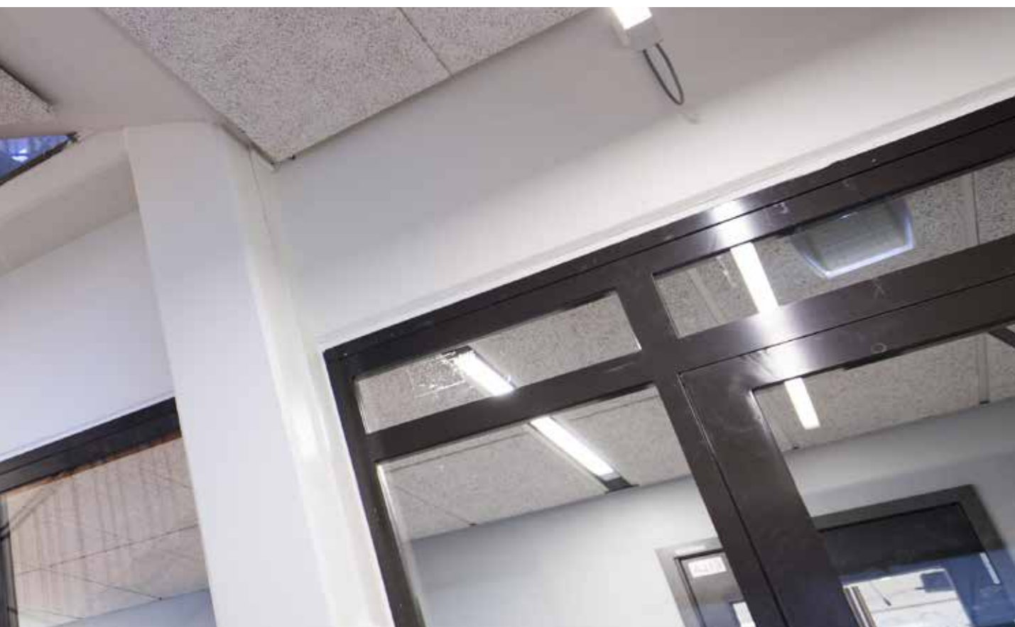
Sågbäcksgymnasiet | Stockholm Yttertak och undertak
