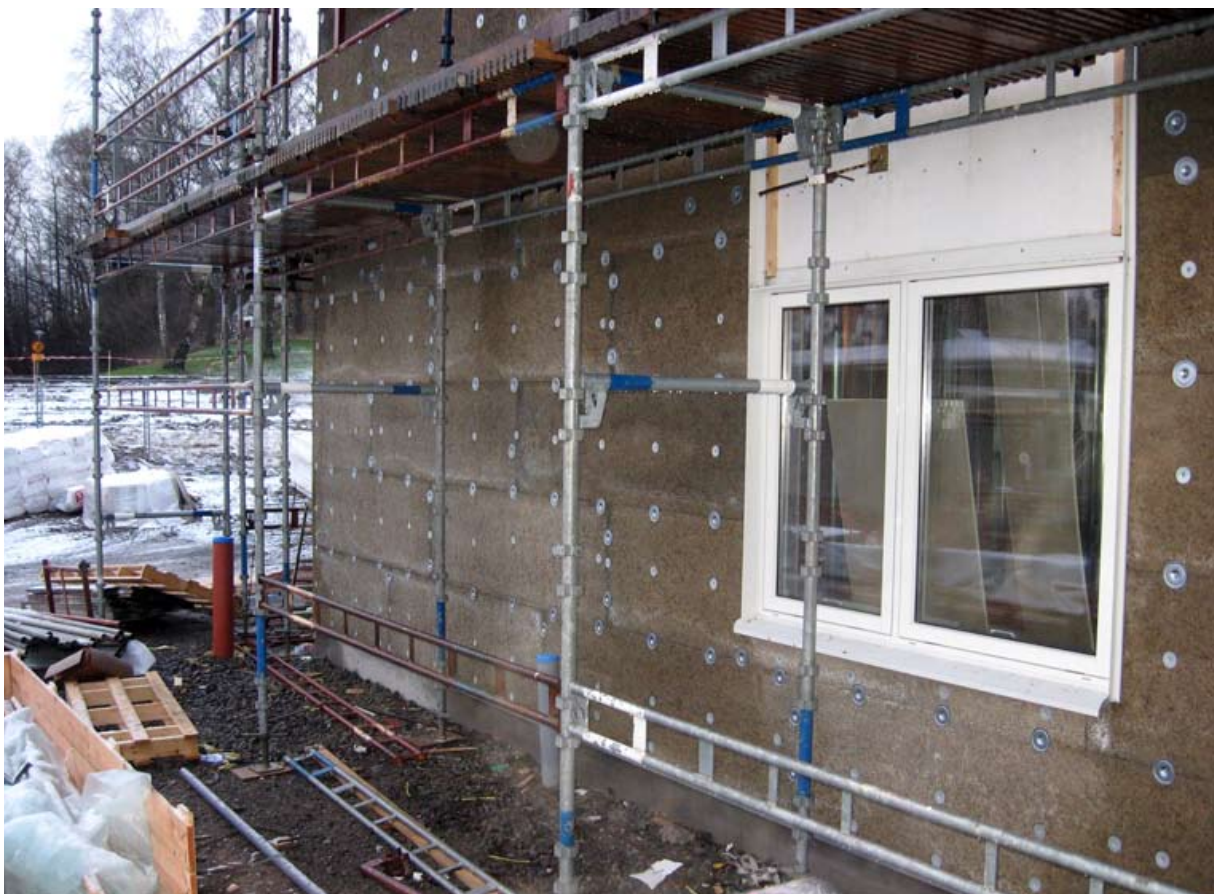
Anledningen till Laholmshems val av 50 mm Träullitskiva som putsbärare var materialets erkänt höga kvalitet och motståndskraft mot påverkan av väder.
